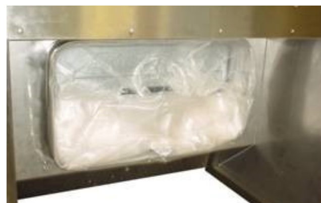
3) Mise en place du sac neuf
