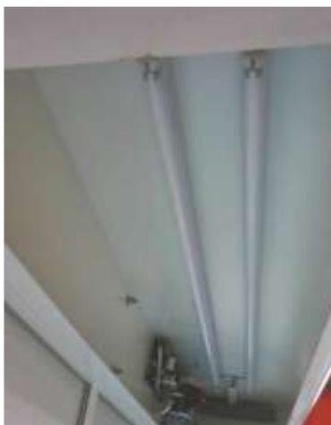
L'éclairage est assuré par tubes fluorescents blancs disposés hors du volume de travail, ceci permet l'isolation de tous les composants électriques suivant la norme ISO 14644.
