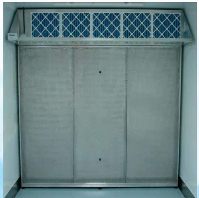
Exemple de mur soufflant en inox
