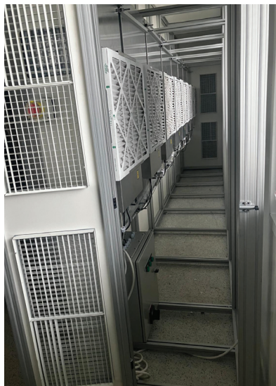
Mur soufflant ISO 5 – Clinique (vue arrière)
